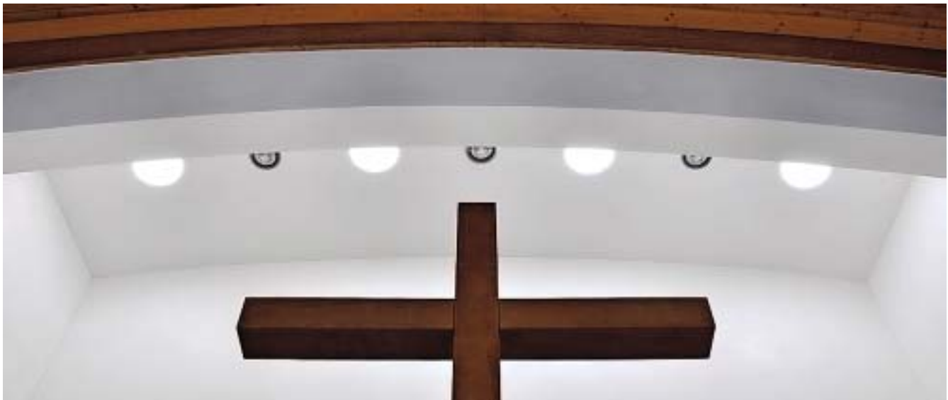
Aus einem ehemals dunklen „Scheinchor“ wurde ein 2 m tiefer Lichtraum hinter dem Altar, erhellt durch vier Lichtröhren durchs Dach.
