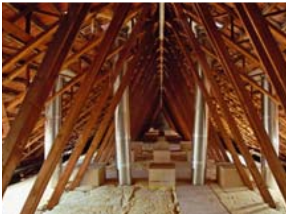
Vier, innen hochverspiegelte Lichtröhren mit Prismenkuppeln leiten Tageslicht in den Kirchenraum.
