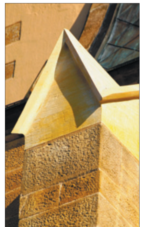
Der Unterschied zwischen alten und neuen Steinen ist deutlich erkennbar.
