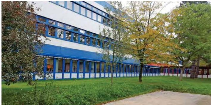
Im Erdgeschoss des Hauptgebäudes liegen die sanierten naturwissenschaftlichen Räume, hier der Fachbereich Physik. FOTO: WALDBLISER
